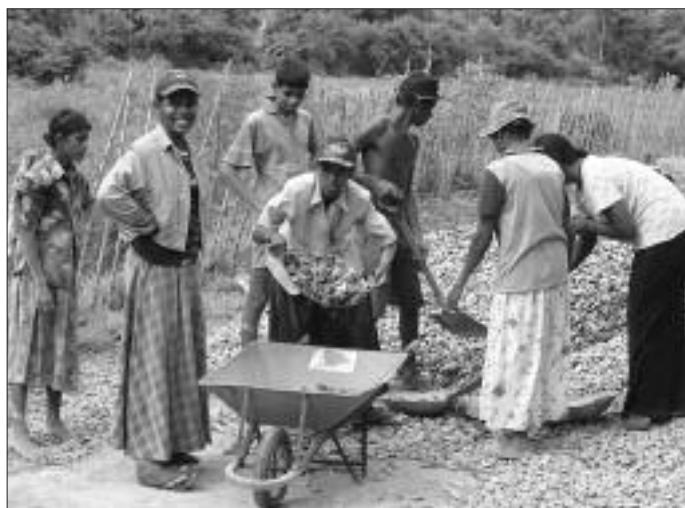
Construction de pont au Sri Lanka après le tsunami
